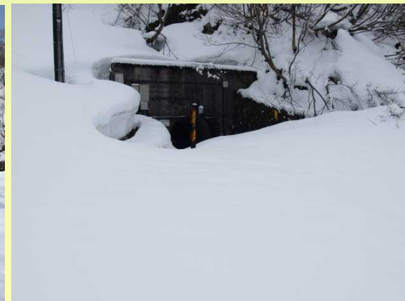
白岩トンネル抗口(水谷平側)
