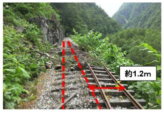
砂防専用軌道は、元 の位置から川側へ 約1.2mずれている。 現在、仮復旧中。
