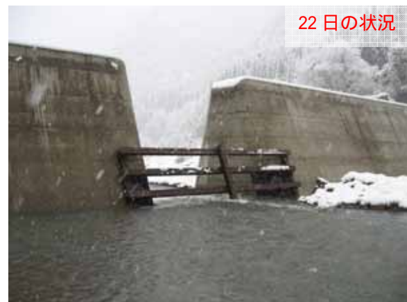
設置後の状況
