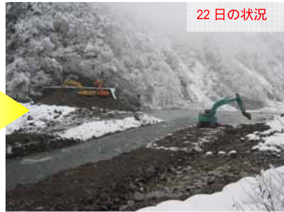
空谷砂防えん堤堆砂敷で掘削
