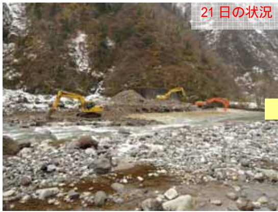
空谷砂防えん堤堆砂敷で掘削
