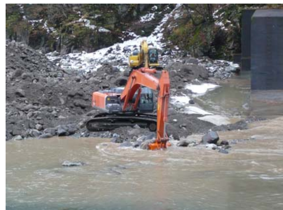
掘削を進める建設機械
