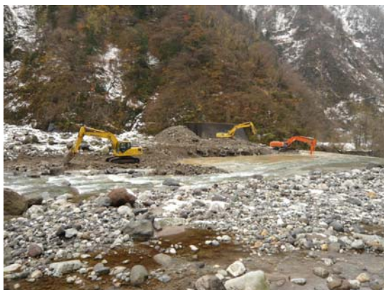
空谷砂防堰堤堆砂敷で掘削
