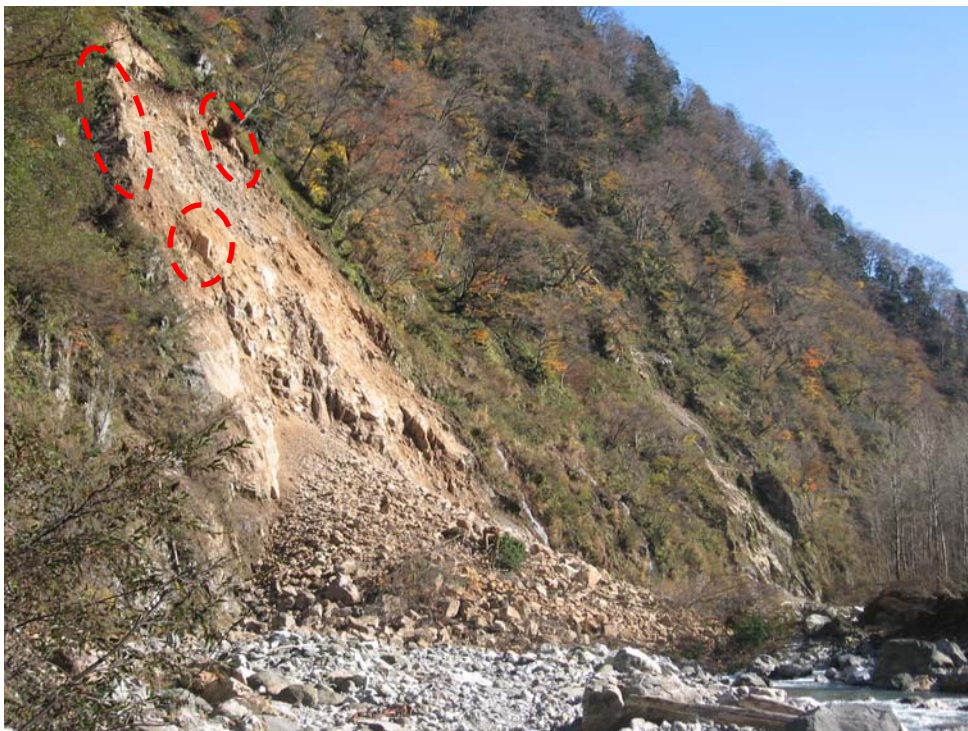
今後崩壊する危険が高い箇所
