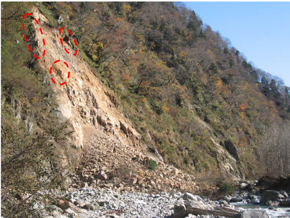
今後崩壊する危険が高い箇所
