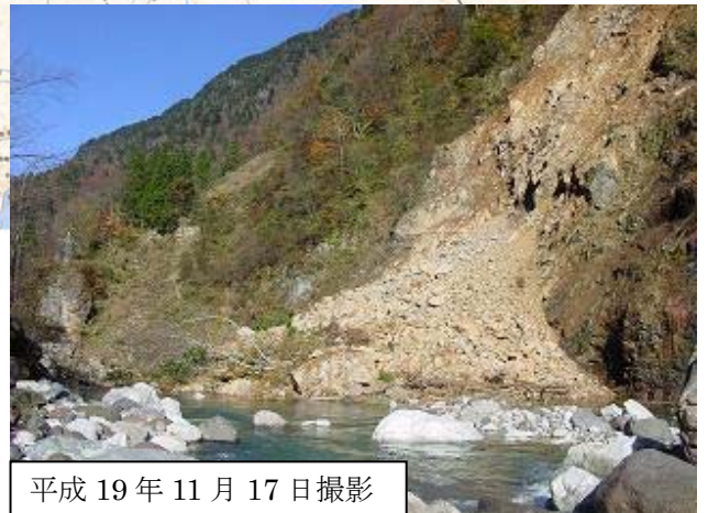
写真-2 崩落土砂の堆積状況
