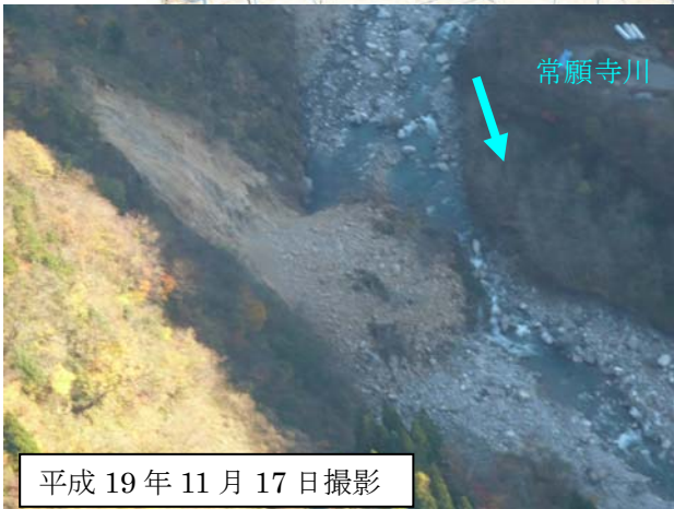
写真-1 崩落土砂の堆積状況
