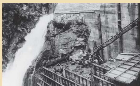
本堰堤非越流部コンクリート打設状況
