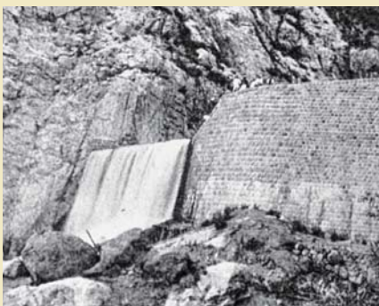
被災前の湯川第一号堰堤 (大正8年(1919年))
