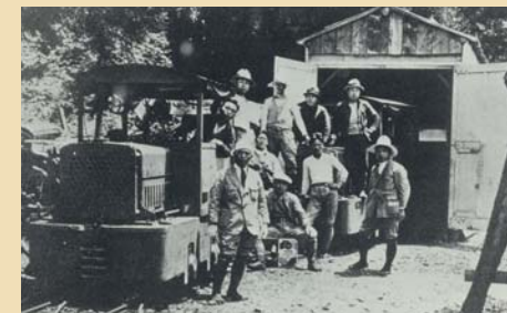
資材運搬用軌道 機関車
