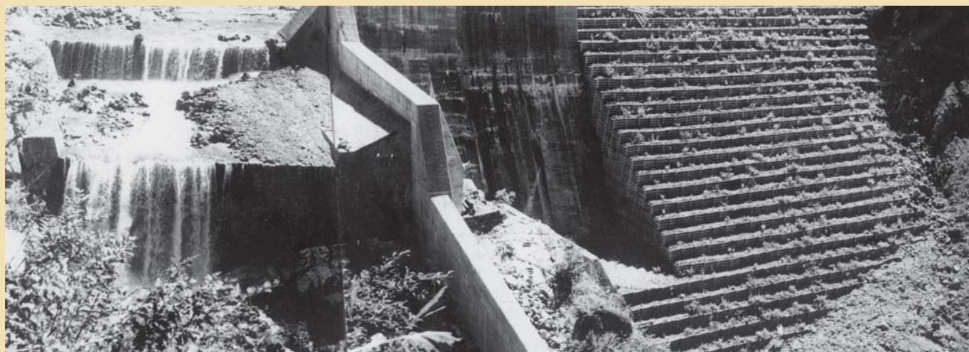
白岩砂防堰堤（昭和21年（1946年））
