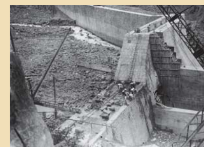
本堰堤天端張石工事状況
