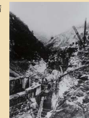
基礎部の工事
