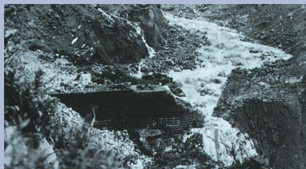
決壊した湯川第一号堰堤（大正11年（1922年））
