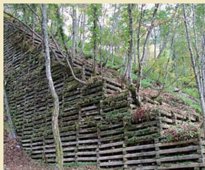
本堰堤左岸下流部の方格柵
