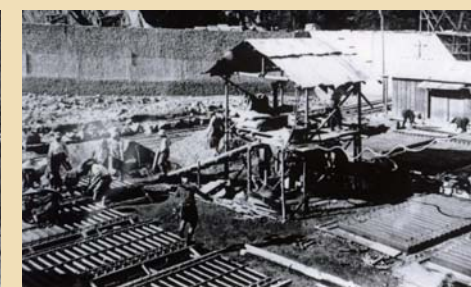
方格枠コンクリート部材の現地製作状況
