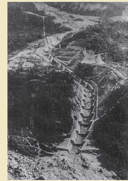
昭和8年(1933年) 直轄災害復旧工事による 泥谷砂防堰堤群の竣工
