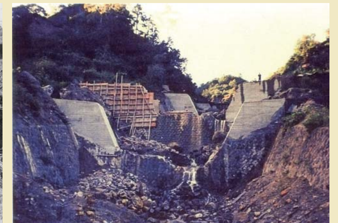
昭和41年(1966年)災害復旧工事状況
