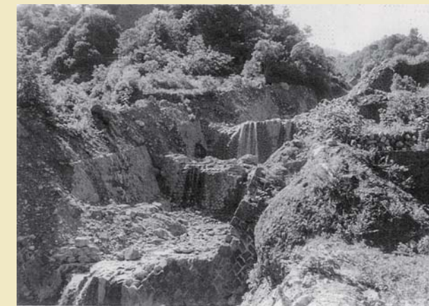
昭和39年(1964年)泥谷砂防堰堤群被災状況
