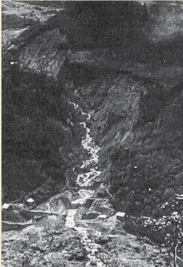
富山県施工堰堤群被災直後 （昭和4年（1929年））
