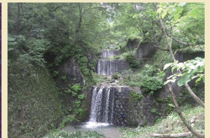
現在の泥谷砂防堰堤群の状況
