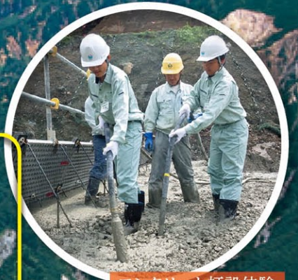
コンクリート打設体験
