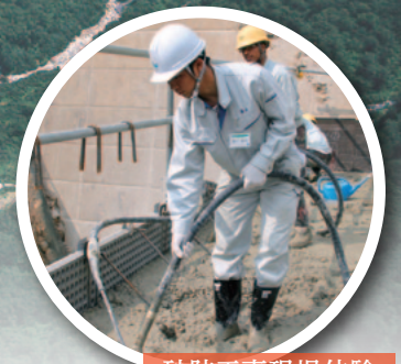
砂防工事現場体験
