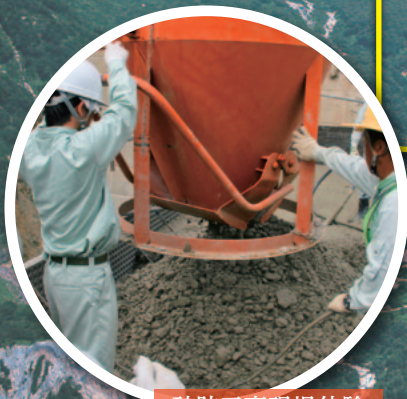
砂防工事現場体験
