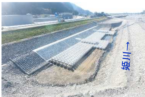
（根継ぎ護岸施工状況）
