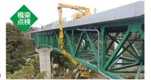
橋梁点検(国道18号 妙高大橋)
