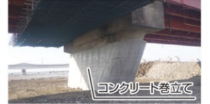
橋脚の補強(国道8号 姫川大橋)
