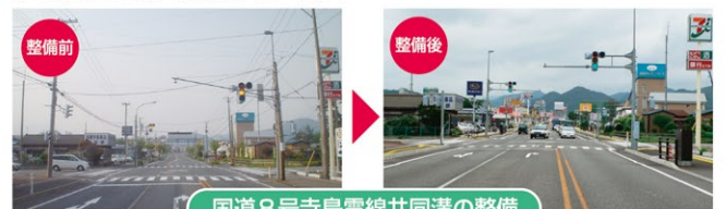
国道8号寺島電線共同溝の整備
