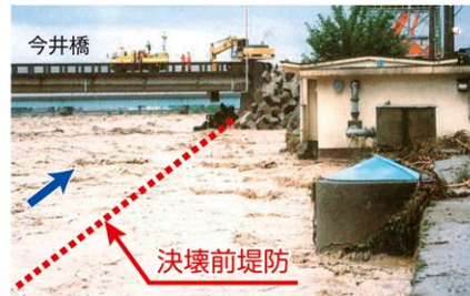
平成7年7月 姫川出水 糸魚川市上刈地区の堤防決壊状況
