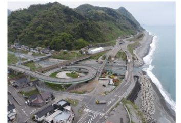
架替工事が進む青海川橋
