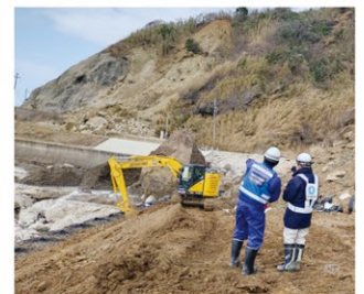
令和6年能登半島地震での輪島市道路啓開作業状況
