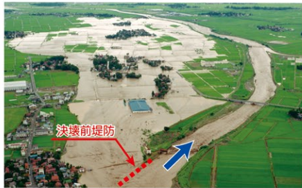
平成7年7月 関川出水 妙高市月岡地先堤防決壊状況
