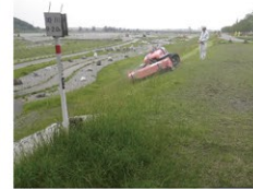
河川堤防除草
