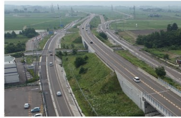
部分開通(H31.3)した上越三和道路
