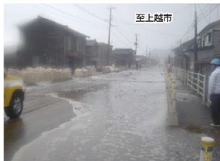
越波による通行止め 平成20年2月(中宿周辺)
