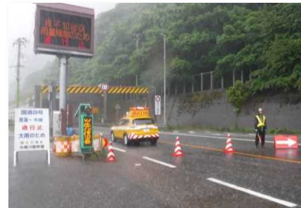
事前通行規制区間の雨量規制による通行止め
