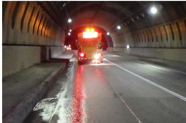
新潟県妙高市毛祝坂地内 散布状況
