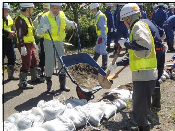
市民による積み土のう工
