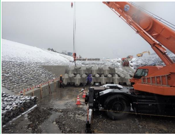
【根固工の設置作業状況】
