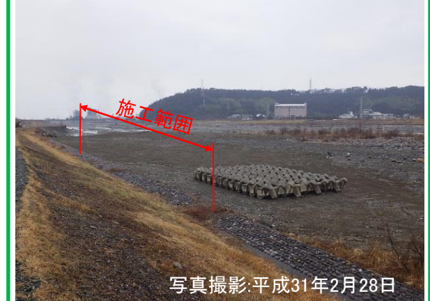
【仮締切撤去・埋戻し完了】
