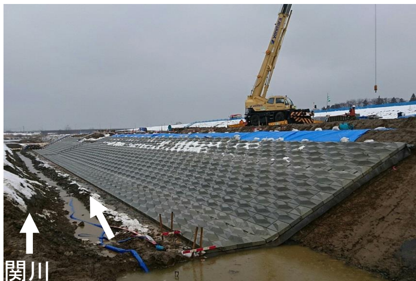
連節ブロック張設置状況
