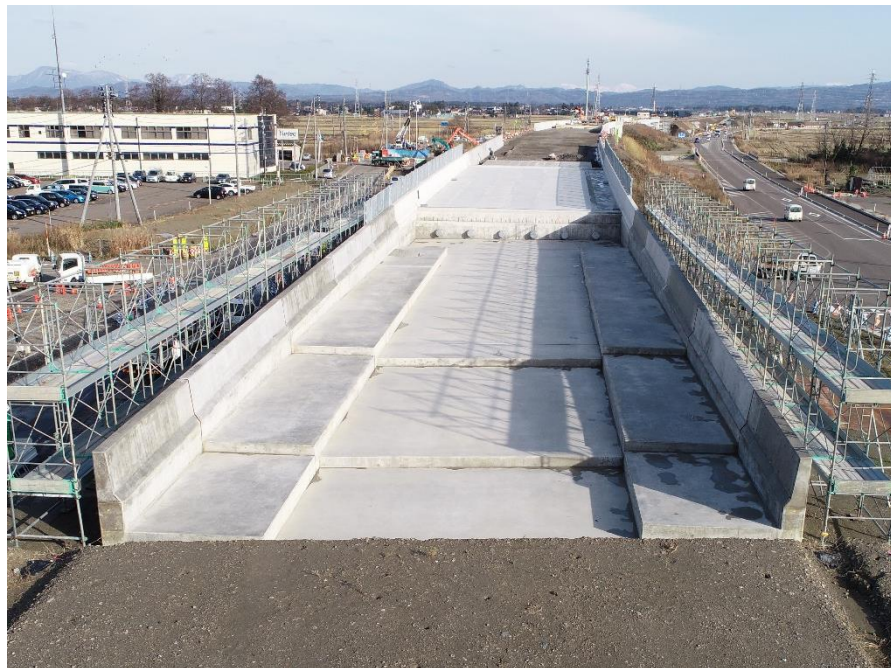
壁高欄工 完了全景
