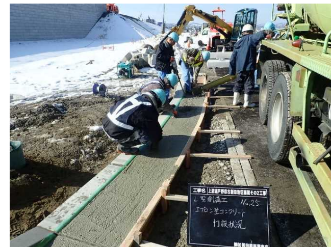
【L型側溝生コン打設状況】
