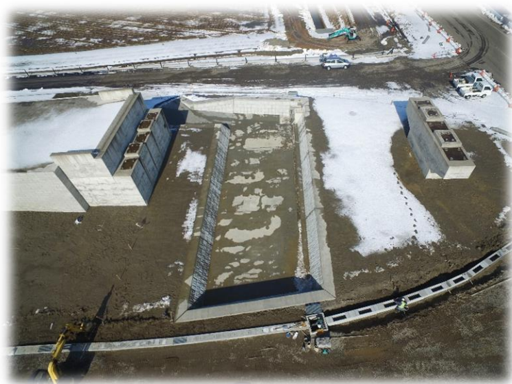
2号調整池 全景
