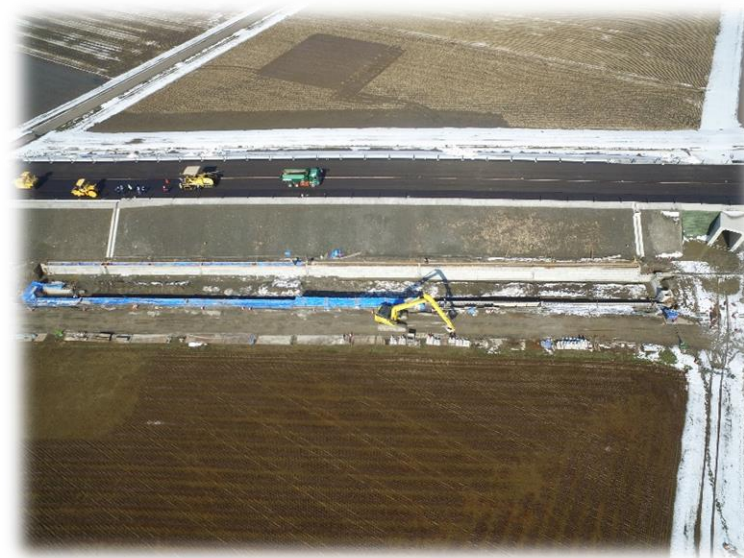
1号調整池 全景
