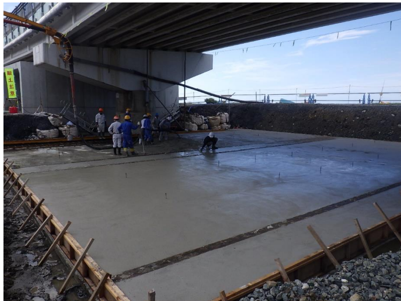
基礎コンクリート打設
