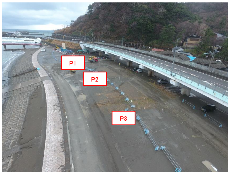
着手前(P3橋脚からP1橋脚を望む)
