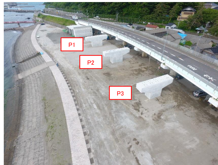
完成(P3橋脚からP1橋脚を望む)
