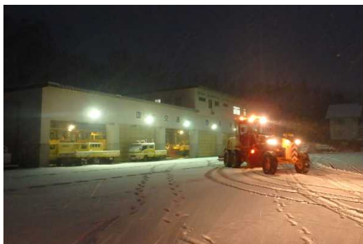
妙高市二俣地先(妙高除雪ステーション)
