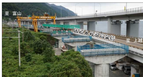
橋桁の施工状況（H28年10月現在）
