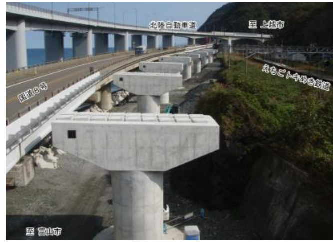
施工状況(歌高架橋 下部工)
