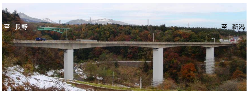
妙高大橋 全景
