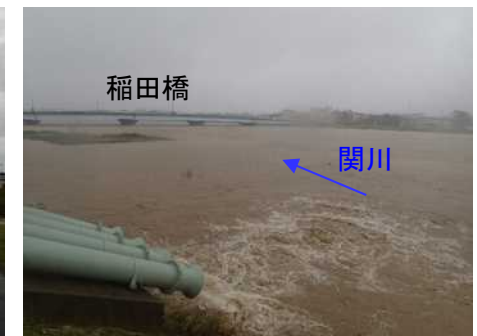
水戸の川排水機 吐出口
