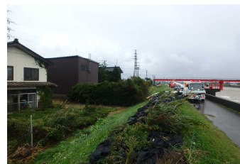
港町第五樋門付近
