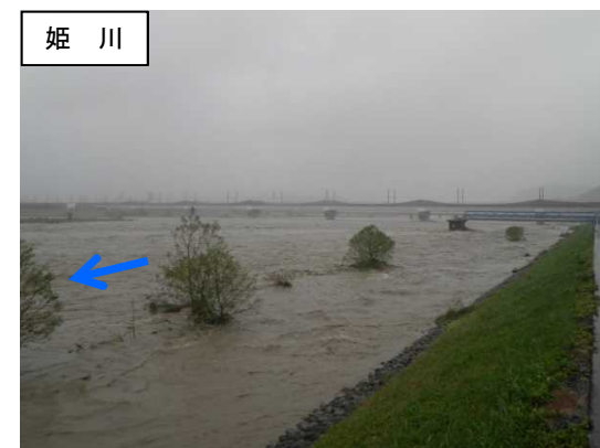
姫川 北陸新幹線姫川橋梁下流(10月23日 7:00頃の状況)
