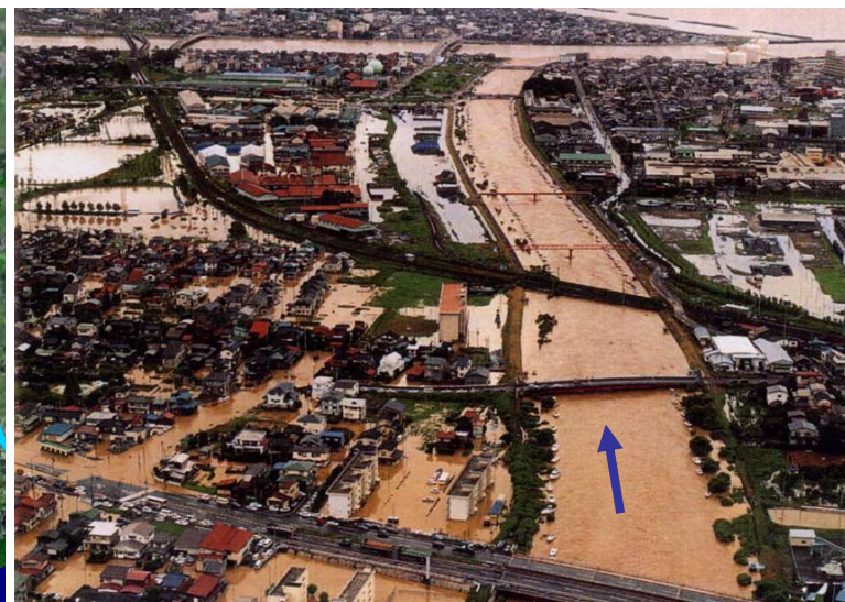
①保倉川沿川被害状況
