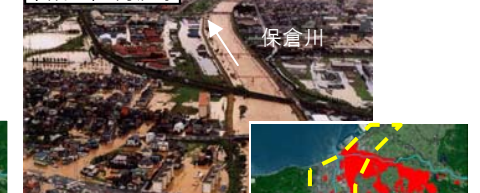
H7.7出水被害状況
