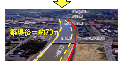
築堤後=約70m
