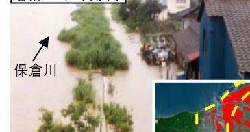
S60.7出水被害状況
