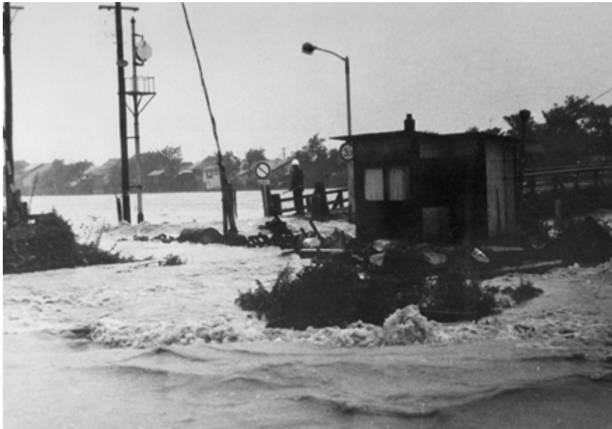
直江津橋付近 溢水
