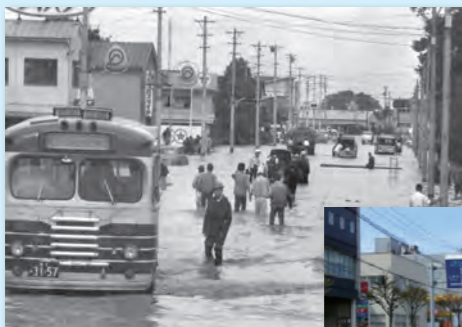
北城町・上越大通り (旧・国道18号)の浸水状況
