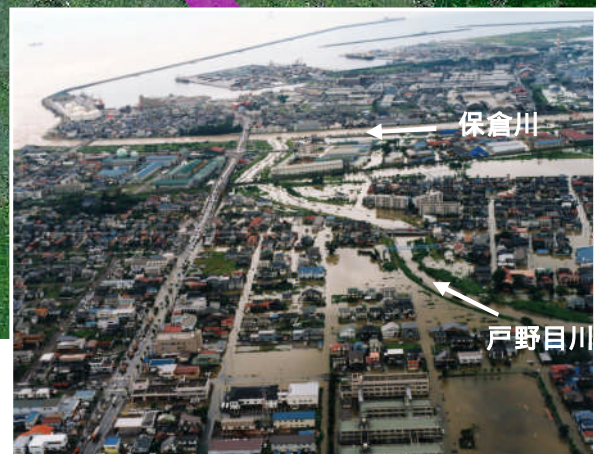
戸野目川沿川被害状況（上流から下流を撮影）
