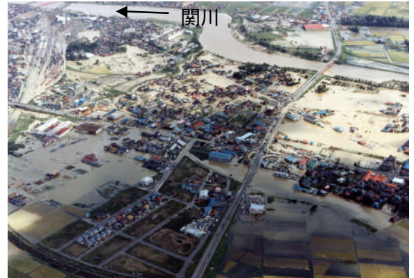
関川大橋付近の浸水状況
