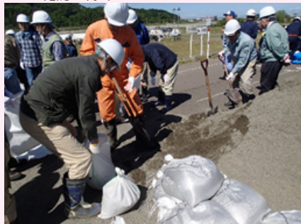
▲水防工法研修
