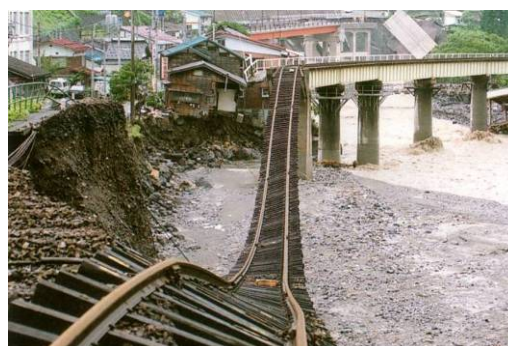
JR大糸線被災状況（糸魚川市平岩地先） H7.7洪水による
