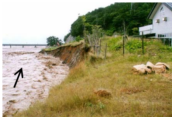
H7.7.11洪水 欠壊状況 (大野地先)
