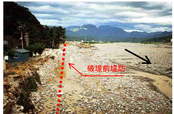
河岸洗掘による破堤状況（糸魚川市上刈地先）
