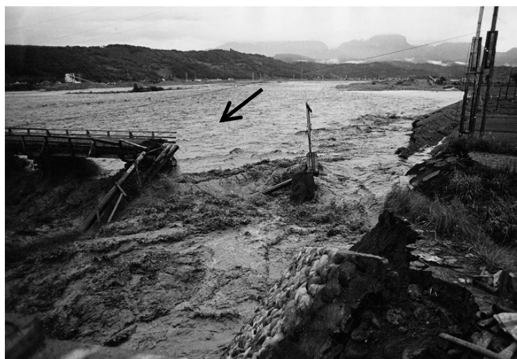
押し流された今井橋と堤防（糸魚川市史昭和編より）
