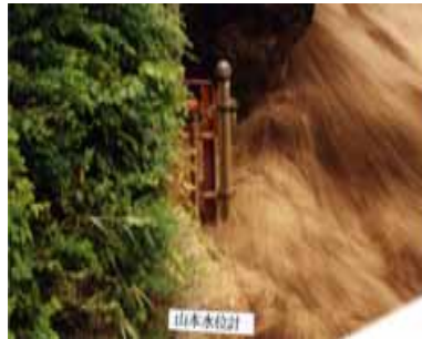
山本観測所水位計の状況 (7/11,18:30撮影)
