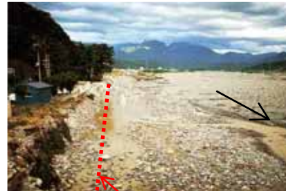
撮影位置①:右岸上流方向を撮影
