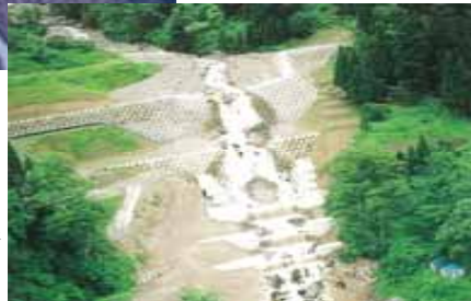
平成7年洪水で土砂を止めた根知川支川中股川第1号堰堤
