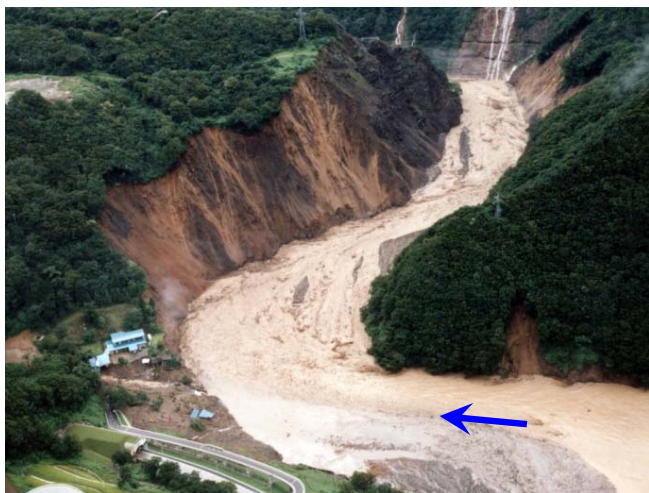
蒲原温泉付近 河岸崩壊状況
