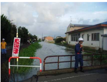
排水前の状況
