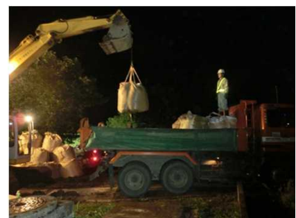
大型土のう製作・運搬（100個）
