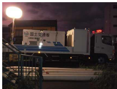
排水ポンプ車稼働状況
