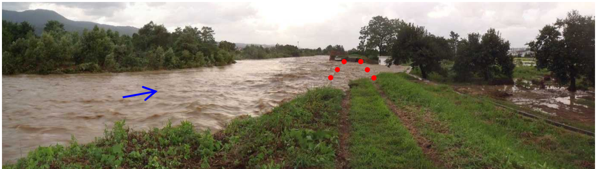
矢代川右岸堤防決壊箇所（妙高市栗原地先）
