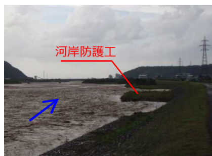
H25.9.16出水状況
