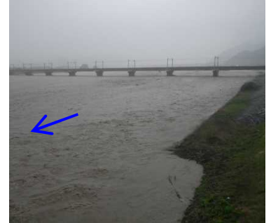
H25.9.16出水状況 ※工事効果により安全に流下
