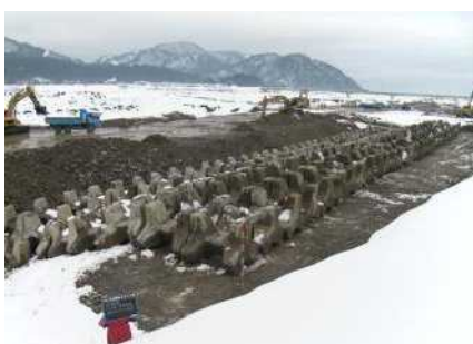
河岸防護工の施工状況
