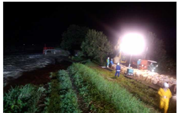
災害応急対応（大型土のう支援）状況
