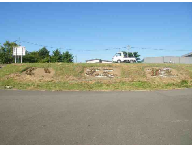
堤防には花文字が完成
