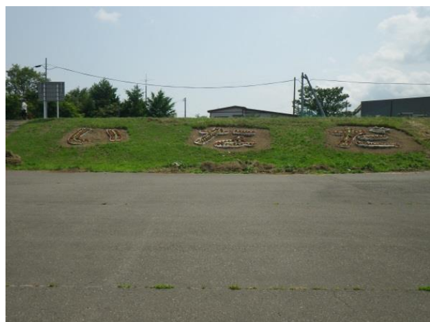
堤防には、花文字が完成（稲田橋上流側）
