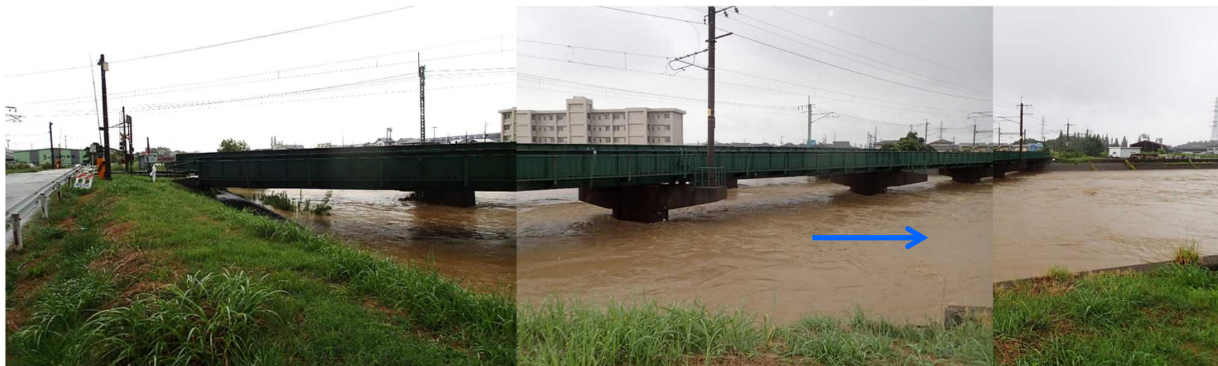
■保倉川 信越本線保倉川橋梁上流(8月28日13:00頃の状況)
