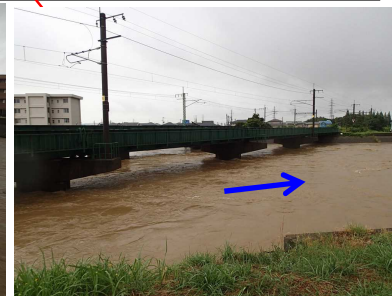
信越本線保倉川橋梁付近 8月28日 13:09
