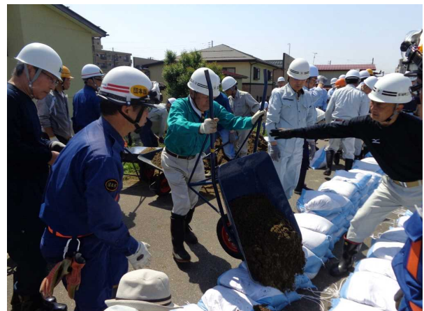
市民による積み土のう工
