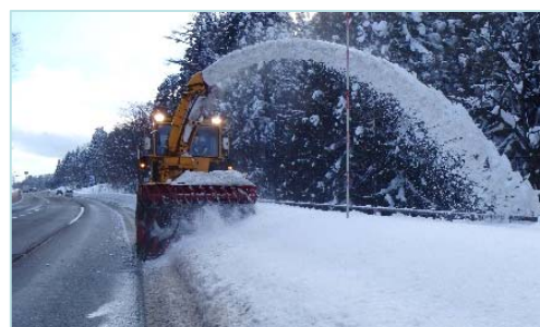
【拡幅除雪：妙高市二俣】
