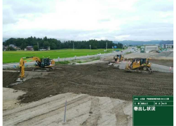
施工状況（路体盛土工 敷均し）
