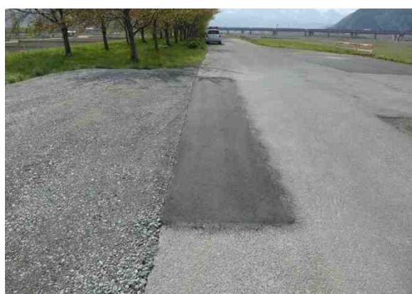
堤防天端舗装の段差解消措置写真(姫川)
