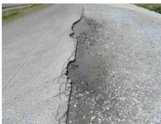
堤防天端舗装の段差状況写真(姫川)
