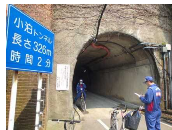
（トンネル坑口擁壁損傷発見）
