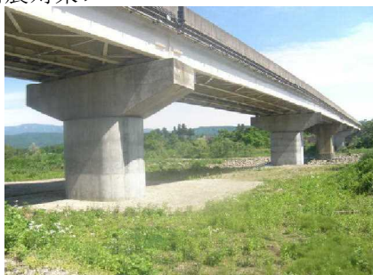
(橋脚コンクリート増厚)
