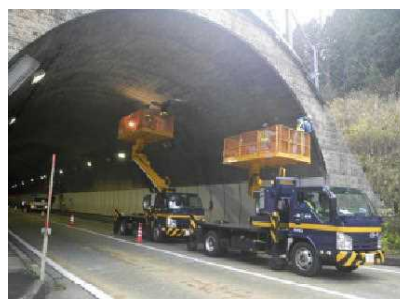
(トンネル点検)
