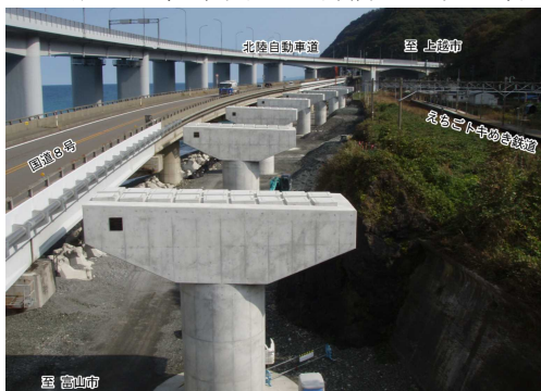
歌高架橋の施工状況
