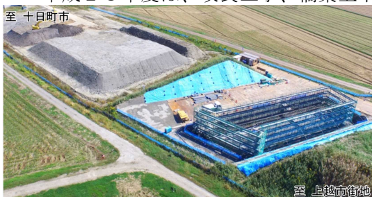
寺～鶴町地区の施工状況
