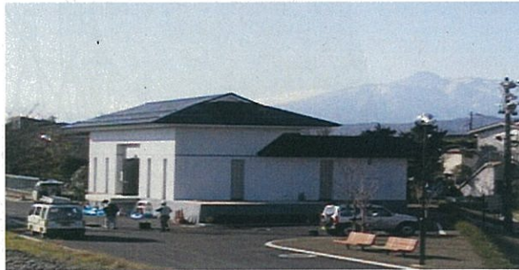
上越消流雪用水導入施設
