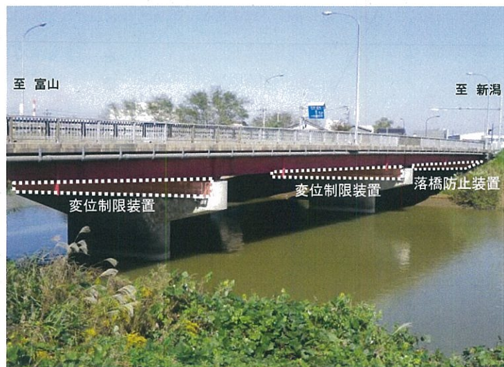
一般国道8号 保倉川大橋（下り）
