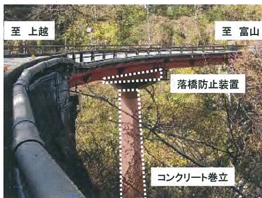
一般国道8号 風波橋
