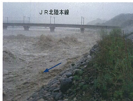
洪水時における須沢地区の水衝部 (平成23年5月融雪洪水時の状況)
