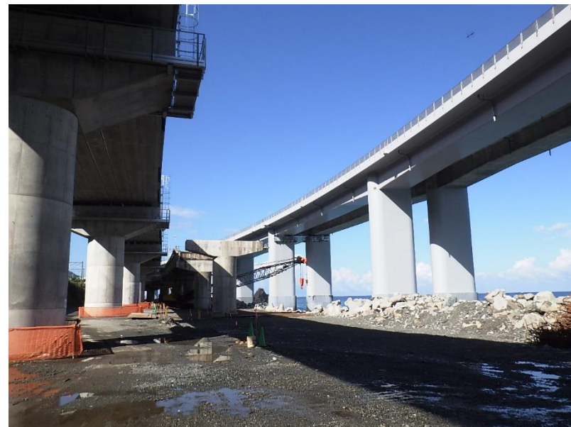
P7橋脚、P7～P9径間撤去完了
