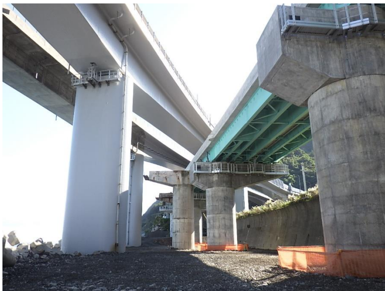
P4橋脚撤去完了
